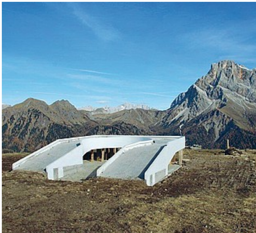
Nel mirino Il balcone delle Dolomiti in costruzione nella zona della Tognola e finito nella bufera
